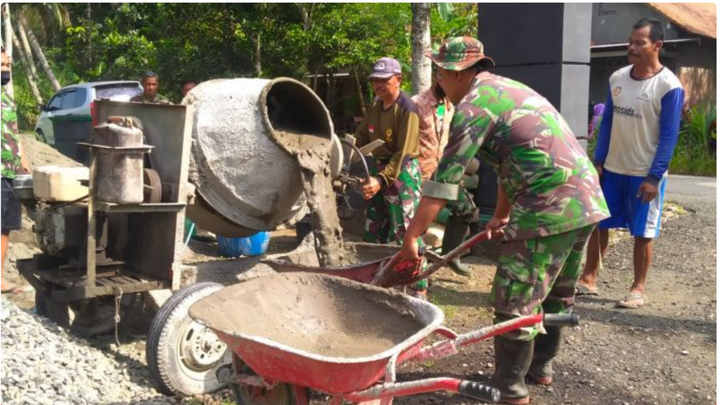
Anggota Posramil Bonorowo Bantu Warga Pengecoran Jalan
